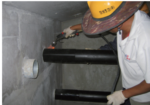
> HDPE - Steel Pipe 접합 작업 전경
